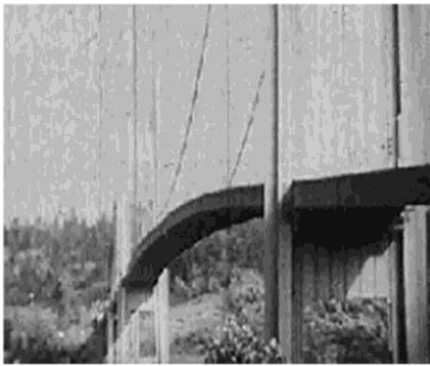
美国纽约马尔克大桥坍塌
